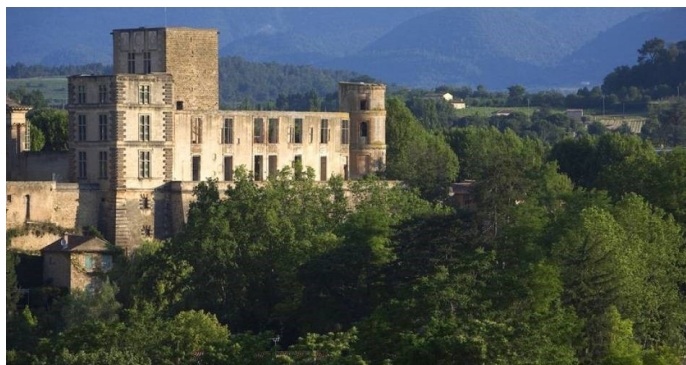
Une des façades actuelles du château de la Tour d'Aygues
