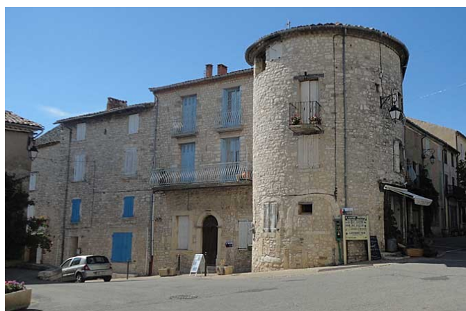
Quelques vestiges de l'ancien château à Sault
